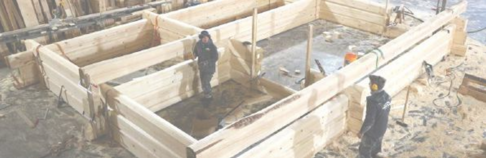
Arbeid i laftehall. Foto: Hendug.no
